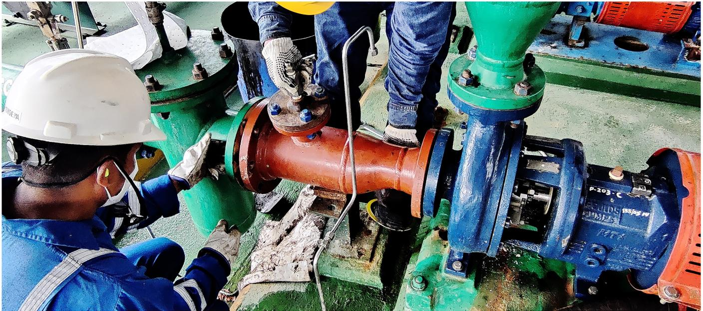
Sustitución de un spool de acero por PE-X revestido para bombeo de agua de formación.
